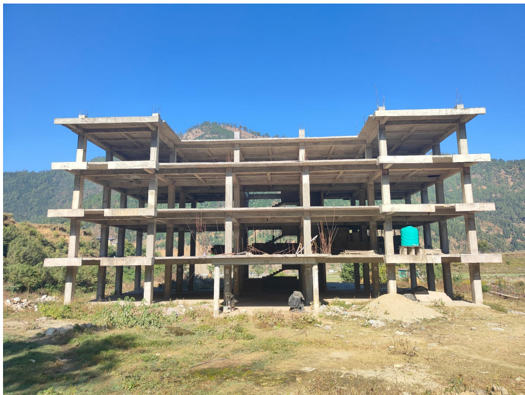
निर्माणाधिन प्रशासकीय भवन
